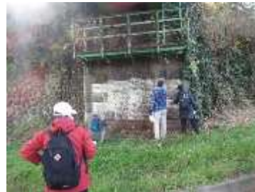
ひの煉瓦が使われた多摩川鉄橋を見学
